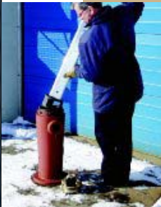
Dévisseur de siège de borne d'incendie
